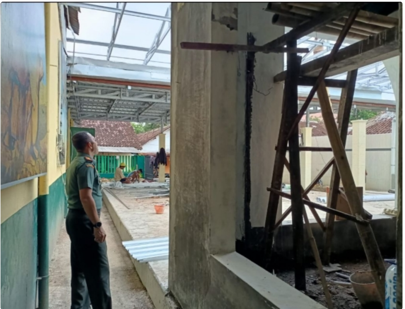
JEMBER - Kondisi pembangunan masjid Al Ihklas di kompleks Makodim
